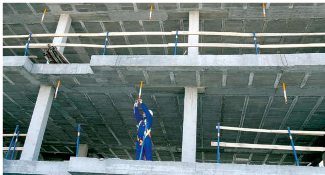
El dispositivo de anclaje Marcelino es especialmente útil cuando faltan los sistemas de protección colectivos.
